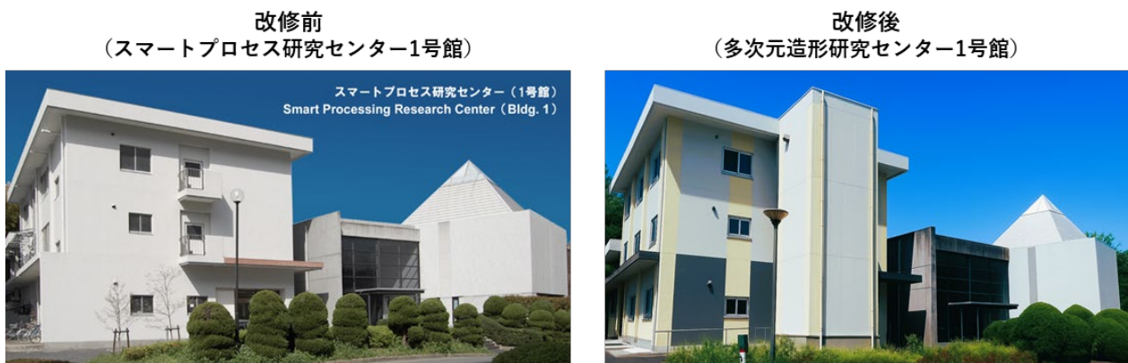
図 7 改修前後の多次元造形研究センター1号館
